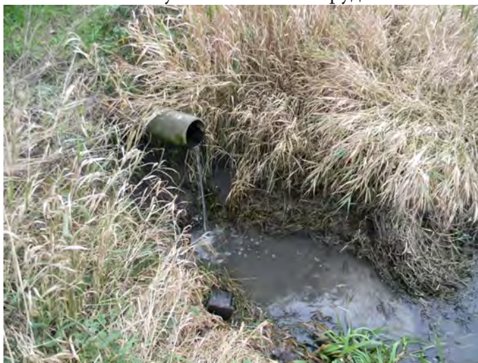
Випуск з очисних споруд
